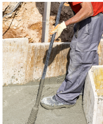
图 2-25 建筑工人用振捣器工作
