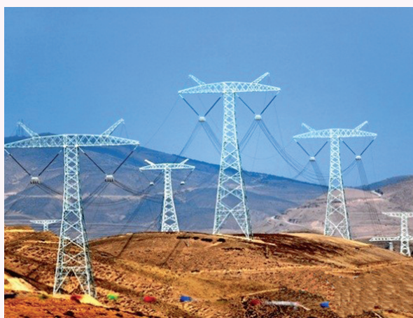
图 7-34 特高压直流输电线路
