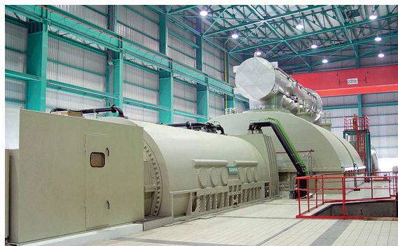
图 7-13 大型交流发电机组
